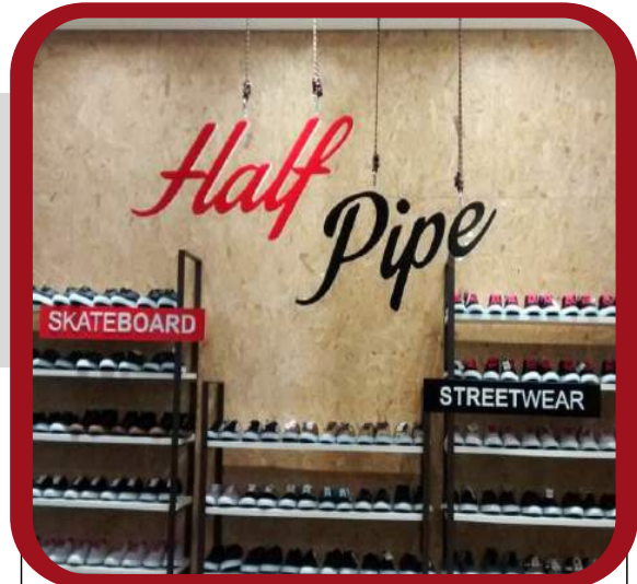
LETRAS EM MDF 15MM COM FIXAÇÃO NO TETO
