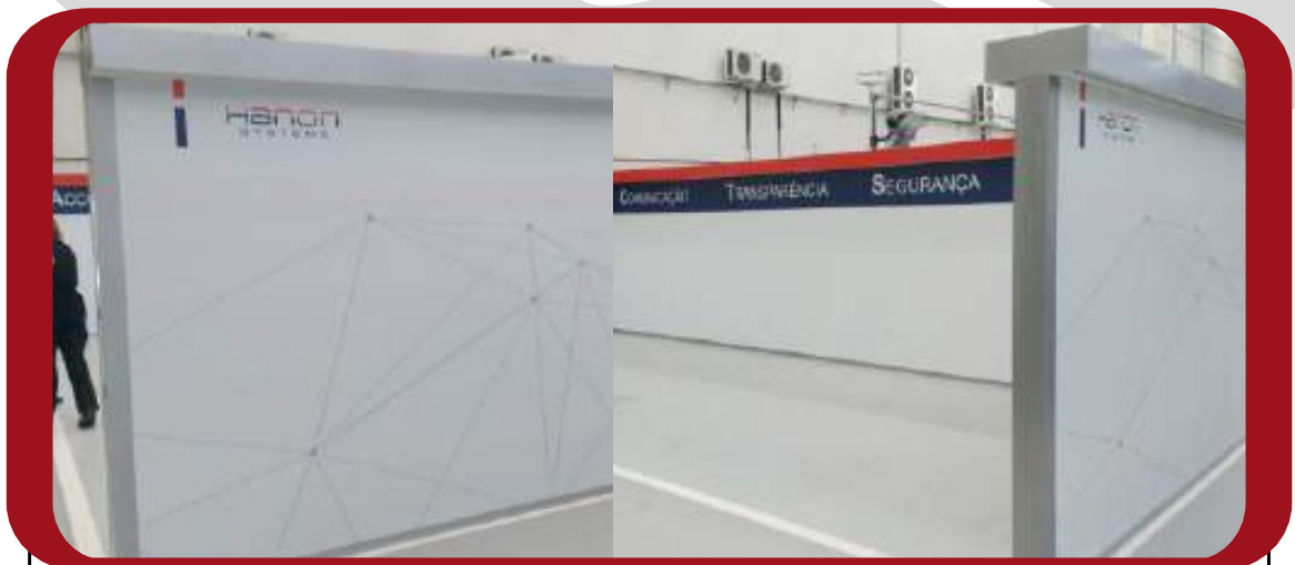
CENOGRAFIA COM ESTRUTURA METÁLICA, PAREDES EM MDF COM REVESTIMENTO EM LONA E SANCA COM ILUMINAÇÃO EM LED
